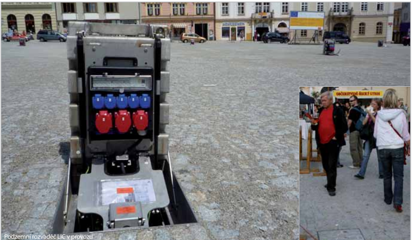
Podzemní rozvaděč LIC v provozu
